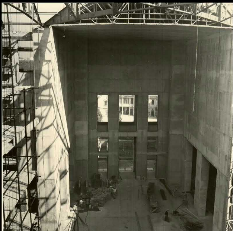
Interno della chiesa in costruzione
